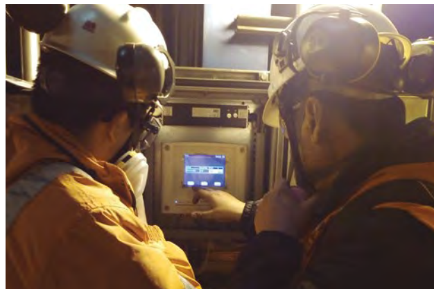
PUESTA EN MARCHA Y CALIBRACIÓN DE ANALIZADOR DE HUMEDAD DE CONCENTRADO DE COBRE
